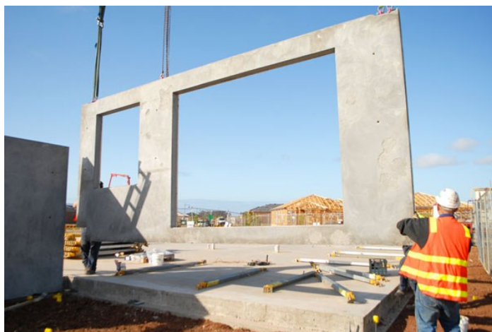
Рис. 6. Сборная панель строительной компании HySSIL из геополимерного ячеистого бетона на основе золы-уноса и шлака [49]
